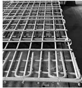
Kunststoff anstelle von Stahl als Bewehrung.
